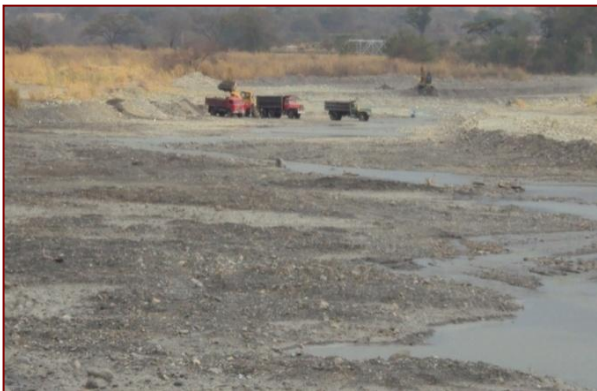
Extracción de material
