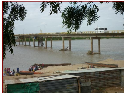
PUENTE MARISELA SOBRE EL RIO APURE SITIO DE CONCENTRACION DEL ESCURRIMIENTO DE LOS ALTOS LLANOS OCCIDENTALES
