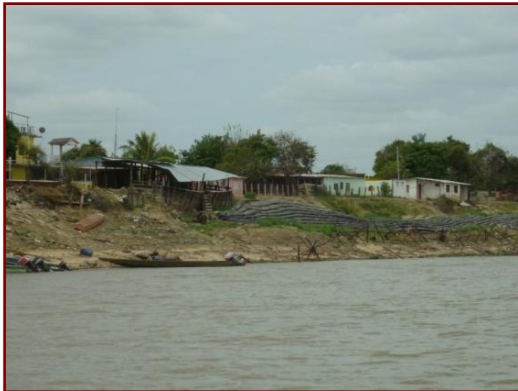
RIO PORTUGUESA EN LA UNION MURO DE CONTENCION DE LA EROSION DE ZAPA
